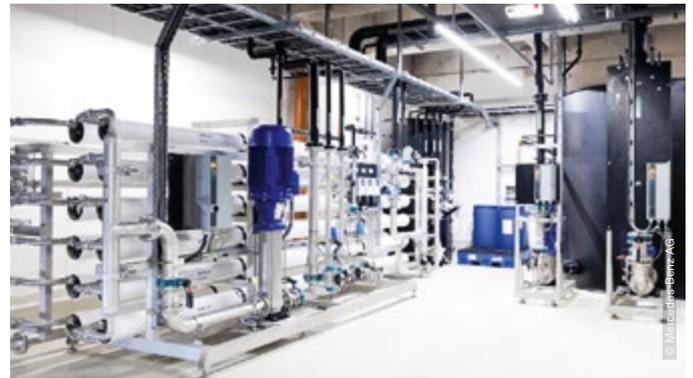
Mehrstufige Wasseraufbereitung bei der Mercedes-Benz AG.
