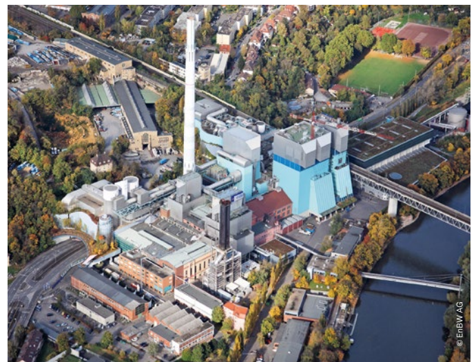
Gas- und Dampfkraftwerk in Stuttgart-Münster.
