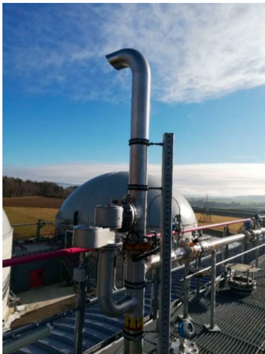
Abbildung 26: Unter / Überdrucksicherung
