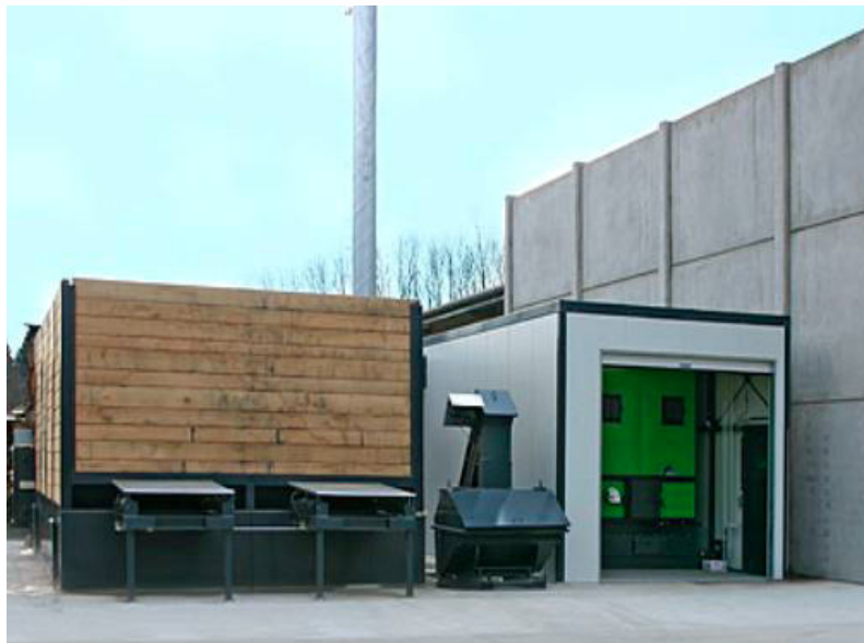
Abbildung 36: Beispiel Holz hackschnitzel Heizung
