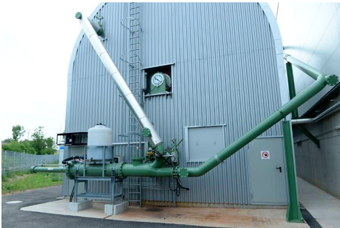
Abbildung 22: Austragsseite Fermenter; Austragspumpe, Impfleitung, Austragsleitung
