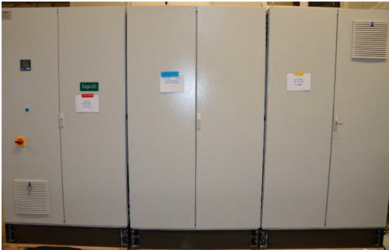
Abbildung 56: Niederspannungsverteilung
