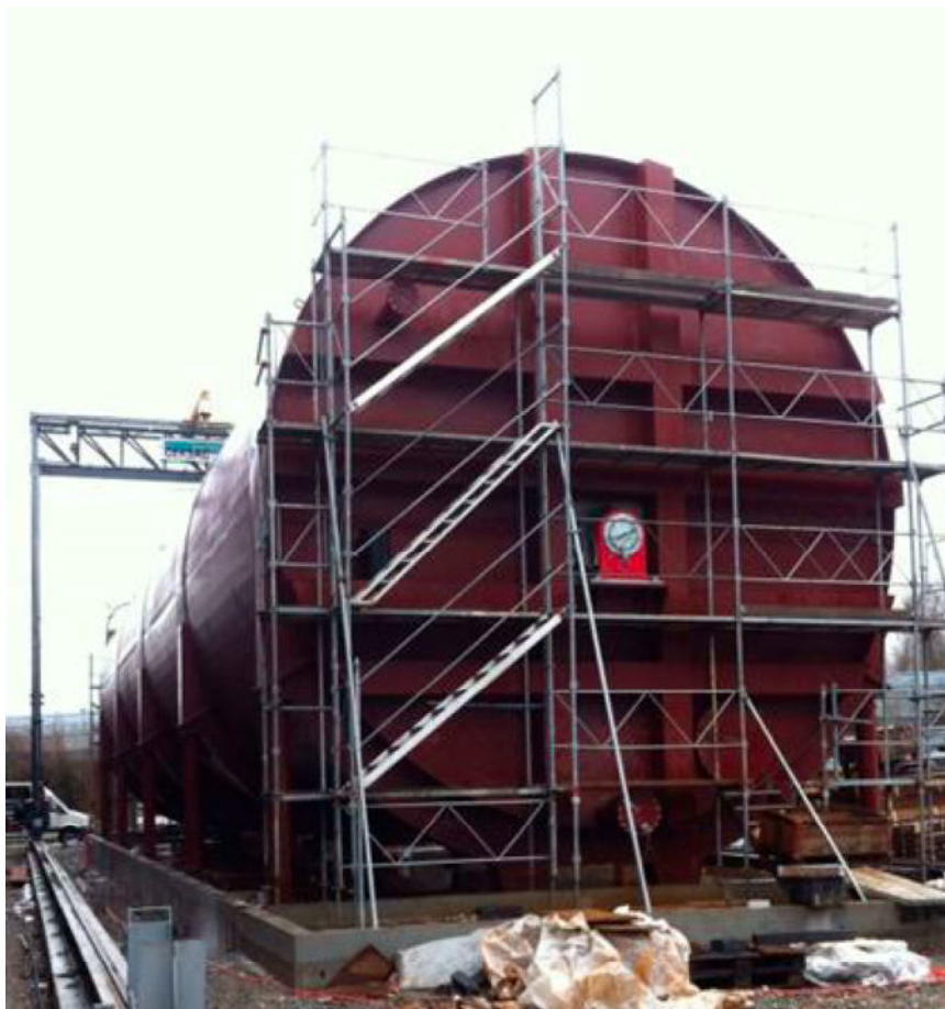
Abbildung 25: KOMPOGAS®Fermenter ohne Verkleidung
