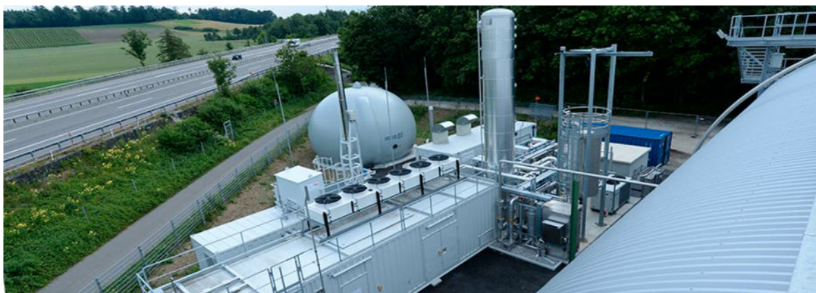
Abbildung 35: Aminwäsche der KOMPOGAS® -Anlage Winterthur
