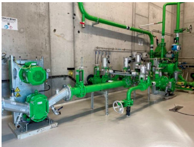
Abbildung 48: Prozesswasserpumpe- Verrohrung
