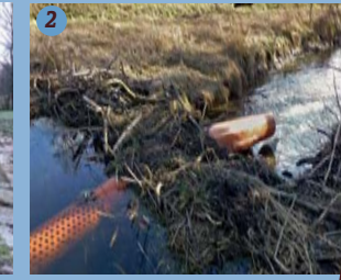
Abhilfe mittels Drainagerohr im Biberdamm
