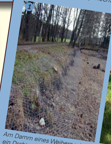
Am Damm eines Weihers wird ein Drahtgeflecht befestigt
