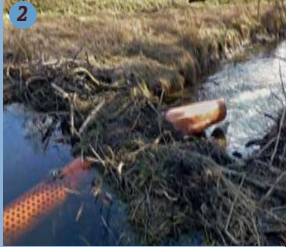
Abhilfe mittels Drainagerohr im Biberdamm
