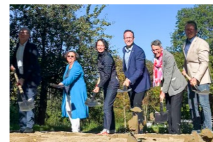
Symbolischer Spatenstich für den Hochwasserschutz am Neckar in Nürtingen.
