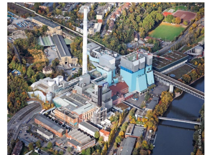
Gas- und Dampfkraftwerk in Stuttgart-Münster.
